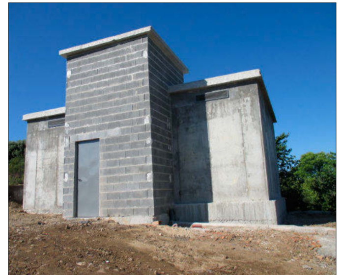
Depósito de agua en la provincia de Salamanca. E.M.
